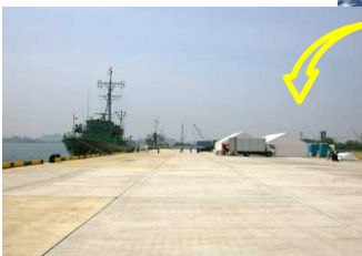
▲高松港朝日地区耐震強化岸壁
